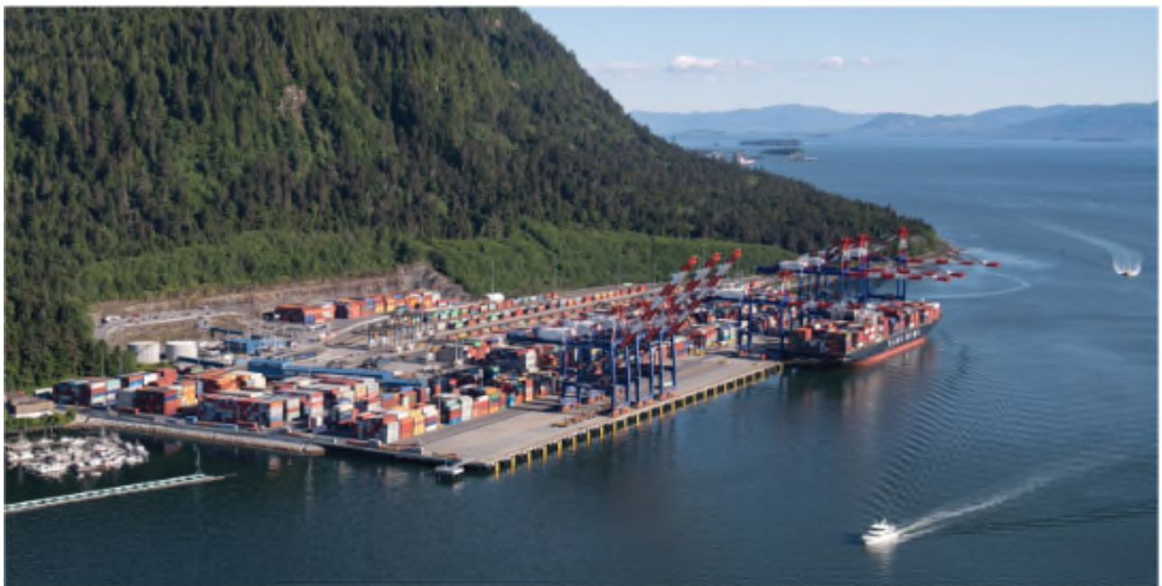
Canal en eau profonde en direction de l'avant-port depuis le terminal de Fairview
